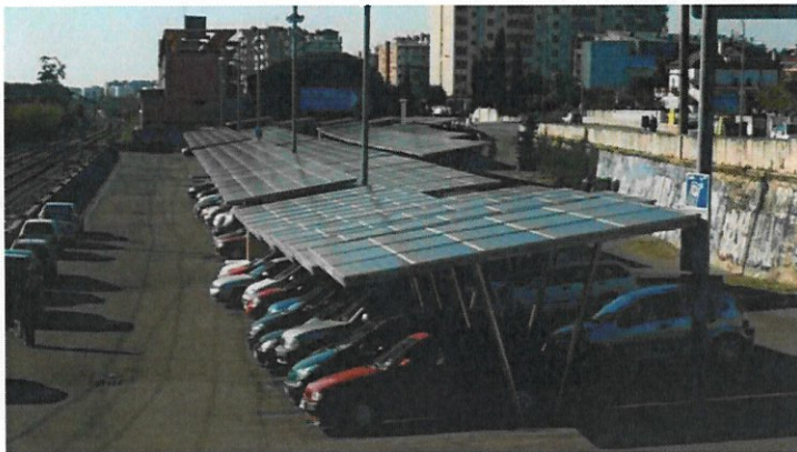
Foto 3. Aparcament amb cobertes fotovoltaïques habilitat a l'accés oest del municipi.
