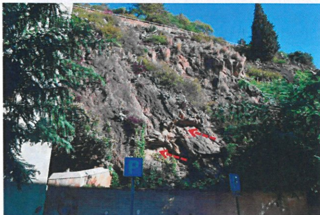
Punt 1: detall del talús on es poden veure cicatrius recents de blocs despresos (fletxes vermelles).
