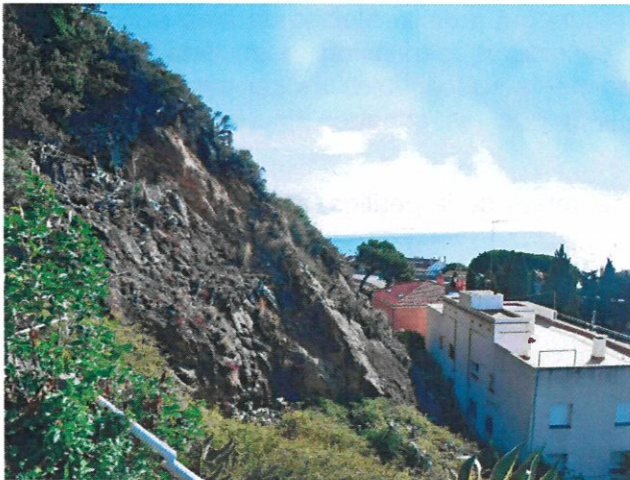
Punt 1: Vista panoràmica on es pot veure el talús darrera del habitatge situat al Camí Ral 43. L'edifici color rosat del costat es troba en el terme municipal d'Arenys i també estaria afectat per blocs que es poguessin desprendre's des del talús.
