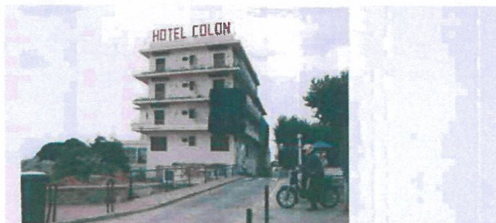
Fotografia núm. 19. Aspecte actual de l'edifici on s'evidencia el caràcter residual de les façanes que s'ofereixen a la banda est i al parc, havent-se perdut la funció urbana que l'antic edifici dels anys 30 aconseguia amb la porxada correguda que connectava la platja, el parc i el passeig dels Anglesos. Any 1998.
