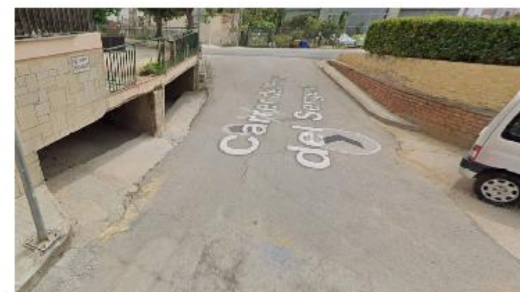
Creuament de la Riera del Gorg amb el c/ del Pont del Sargent i calaix. Font: Google
