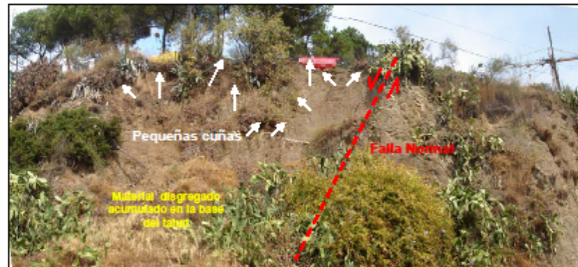
Figura 19. Disposición geométrica de la rotura en Cuña. (Pág 42. Ingeniería Geológica. Aut. González de Vallejo).
