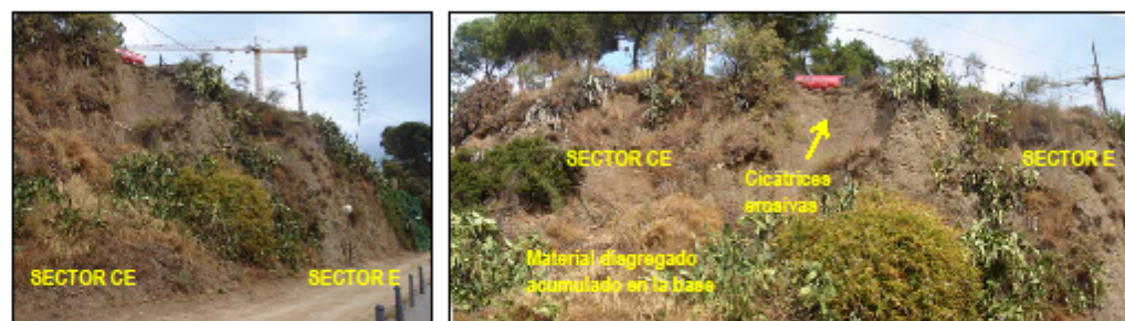
Fig.8. Vista general del Talud del sector central. Fig.9. Detalle de la localización de indicios de inestabilidad.
