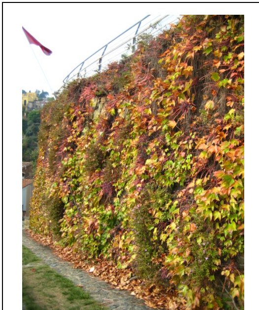
Paret de l'entrada. S'haurà de renovar les Lantana montavidensis
